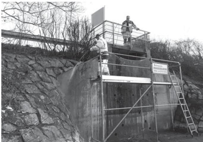
Aktuell wird die Flügelmauer am Auslaufbauwerk saniert (Bild: Gemeinde Kernen). In einem ersten Schritt werden die Betonflächen (Flügelmauer) mit dem Hochdruckreiniger gesäubert. Danach wird der Beton in drei Schritten saniert und beschichtet. In KW 12 wird mit der Befüllung des Beckens begonnen. Dazu wird Wasser von den Tiefbrunnen bei der Hangweide mit Fässern zum Regenrückhaltebecken Katzen transportiert. Geplant ist, das Speicherbecken bis spätestens zum 31. März wieder in Betrieb zu nehmen.
